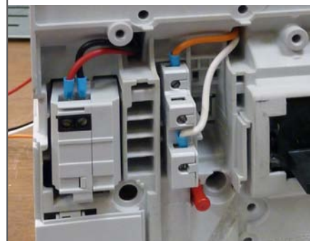
Retirer les obturateurs arrière amont et aval.
