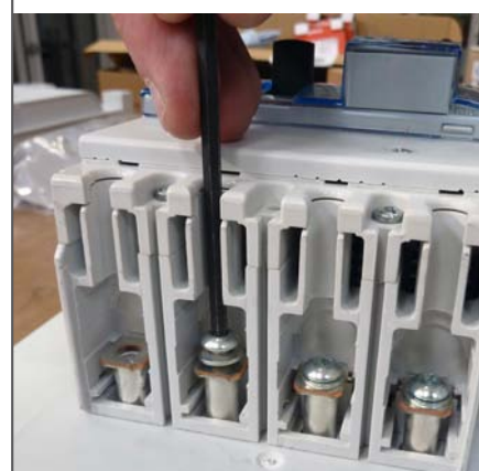
Serrer les connexions électriques amont grâce aux huit (ou six) vis fournies avec le disjoncteur (couple de serrage 7 N·m).
